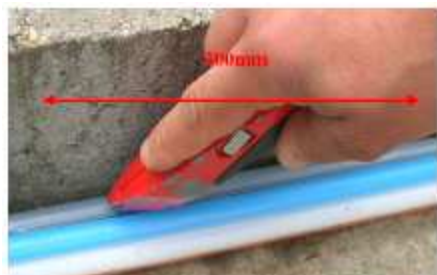
1. Faire une ouverture de 30cm à l'aide d'un outil contondant
